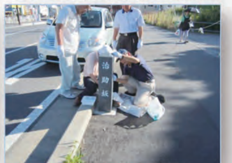
「治助坂の道標」補修作業 2012.8
