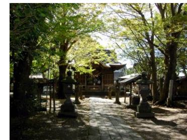
八坂神社・本殿 取手宿の産土神として江戸初期から信仰を集めて来ました本殿の彫刻は精巧で高い建築技術を示しています
