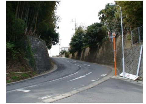
⑦ 元豆腐屋がある本郷西坂
